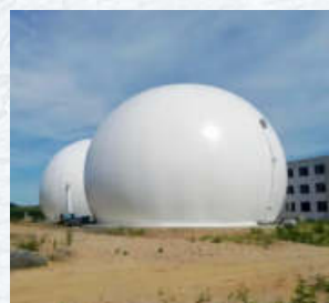
4000立方两套辽宁鞍 山大型秸秆沼气项目
