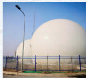
5000立方两套西安 中节能污水处理项目
