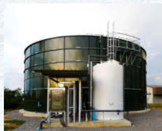
山东烟台1000m 3 储水罐
