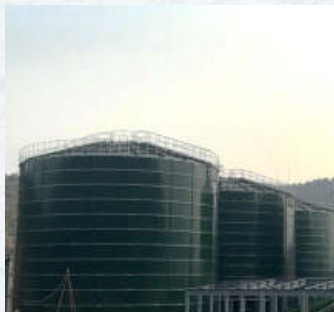
四川生物质能源项目 三套3000m 3 CSTR罐
