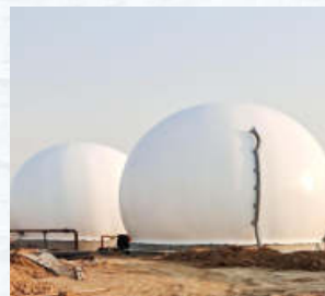
1000立方两套河北以 岭药业污水处理项目
